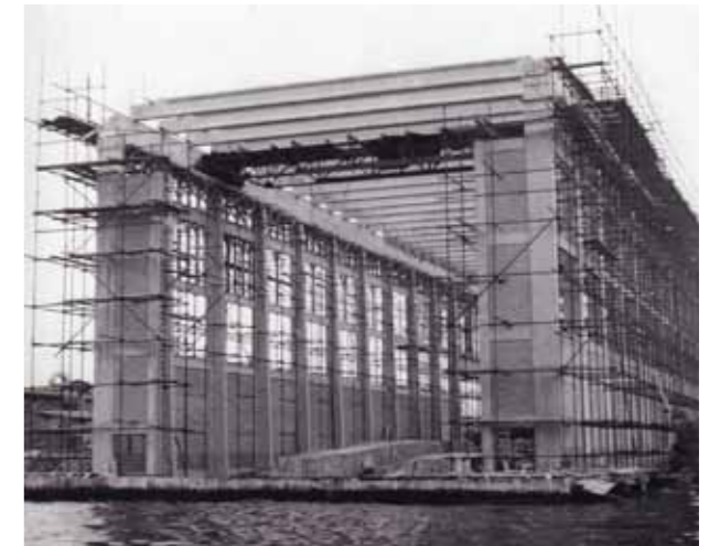
Scheepsbouwoords geheel uitgevoerd in spanbeton, gebouwd voor de productie van twee mijnenvegers voor de Marine en andere zeer grote vaartuigen, 1954. 31
