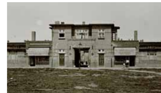
Hoofdgebouw in de ommuring van de controlewoningen met de poort die om 9 uur 's-avonds dicht ging, 1923.
