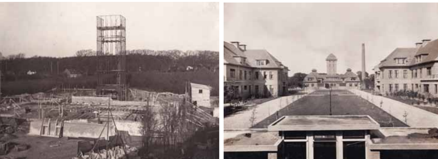
Links: Skelet van de watertoren en de fundering van het zogeheten 'economiegebouw', 1928. Rechts: Centrale as van het gebouwencomplex van Vogelenzang met paviljoens aan weerszijden en aan het eind de watertoren met het economiegebouw, 1929.
