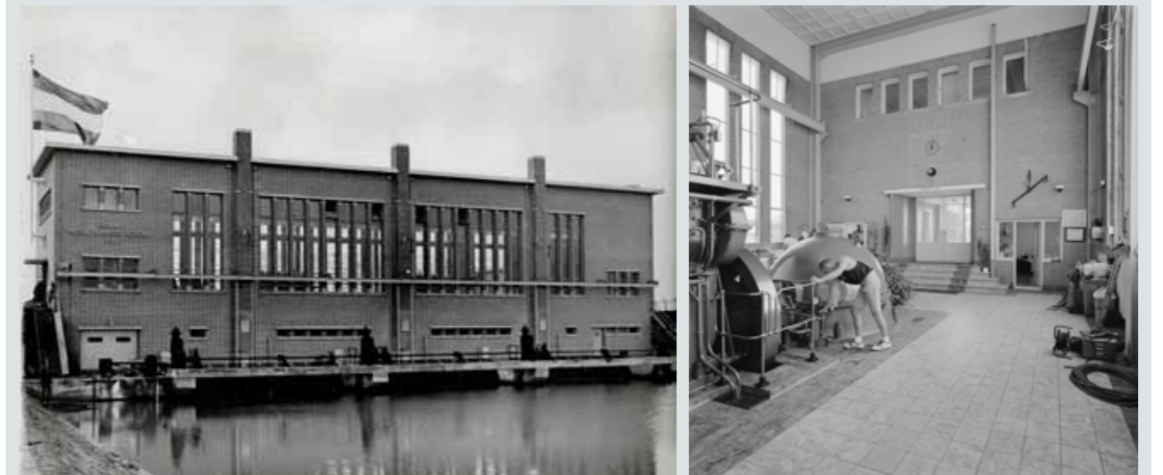
Linksboven: Boezemgemaal Gouda, zuidzijde. Rechtsboven: locatie boezemgemaal Gouda. Linksonder: Boezemgemaal Gouda, noordzijde met twee bouwlagen, 1936. Rechtsonder: Boezemgemaal Gouda, interieur van het bovengebouw, 1966.
