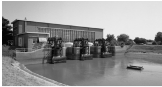
Boezemgemaal Gouda, zuidzijde, 1996.
