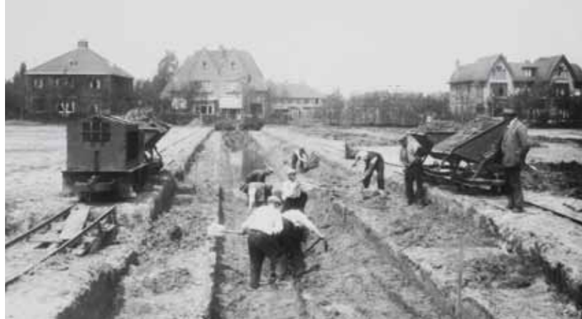
Aanleg Leidse Hout en werkverschaffing. Op de achtergrond huizen aan de Warmonderweg in Oegstgeest, 1929-1932. 31
