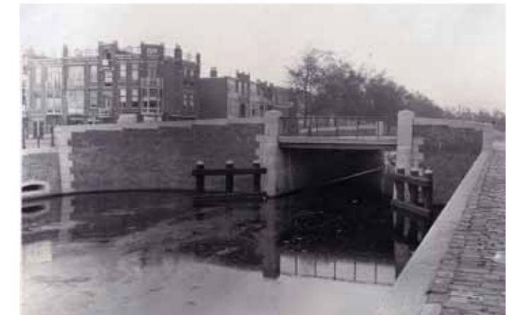
Brug over de Loosduinse Vaart, Den Haag, 1927-1928.
