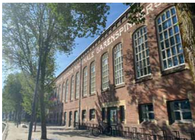
NV Machinale Garenspinnerij, Gouda. Boven: Stalen dakconstructie, 1916.
