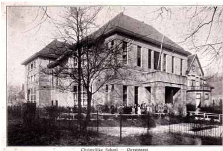
Foto ter gelegenheid van de grote verbouwing en uitbouw van de lagere school aan de Endegeesterstraatweg, naar ontwerp van architect A.T. Kraan. 11
