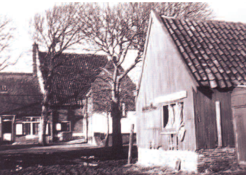
Boerderij aan De Voscuyl 17, vroeger Rhijngeesterstraatweg 91. Van 1934 tot 1960 de boerderij van de familie Heemskerk, vroeger Rhijngeesterstraatweg 91; in 1962 dreigde deze boerderij door de gemeente te worden gesloopt maar na hevig protest kon het hoofdgebouw als rijksmonument worden behouden.
