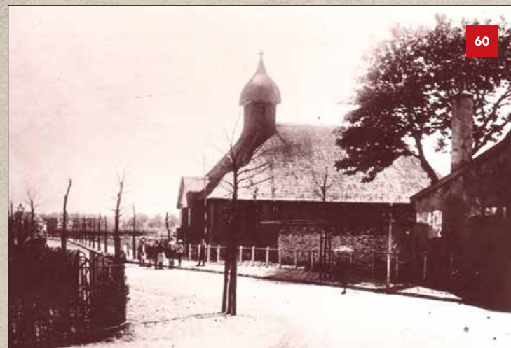
De Rehoboth-kapel aan de Willem de Zwijgerlaan, gezien vanaf de Geversstraat. Het is ontworpen door architect H. Wilms, gebouwd in 1923 en tot 1933/1934 gebruikt door de Gereformeerde Kerk. Toen werd de Mauritskerk gebouwd en in gebruik genomen. Vervolgens gebruikten de Vrijzinnig Hervormden het gebouw onder de naam Willem de Zwijgerkerk. Sinds 1973 is het een woonhuis.
