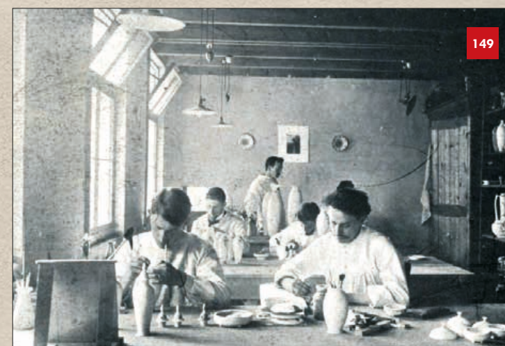
1908. Aardewerkfabriek 'Amphora'. Op het Werninkterrein, tussen Rijn en spoor in het huidige Leiden, stond tussen 1852 en 1907 dakpannenfabriek 'De Nijverheid'. Hier werd de Oegstgeester dakpan gemaakt. Toen deze fabriek in 1907 stopte, zette één van de eigenaren, de heer Sillevolt, een aardewerkfabriek op die jugendstil vazen maakten. Deze vazen kregen landelijke faam vanwege de mooie producten maar ook omdat hij een procedé ontwikkelde waarbij het glazuur sterk en glad bleef. Op de foto zien we de schilders aan het werk met de afbeeldingen. De fabriek produceerde van 1908 tot 1933 en is de naamgever van de Amphoraweg.
