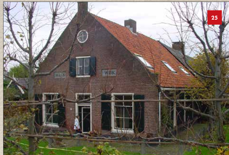
Boerderij Haaswijk. De oudste gegevens over deze boerderij stammen uit 1606, maar uit deze akte blijkt dat het om een boerderij gaat die al veel langer bestaat. In 1839 moest de boerderij wijken voor de aanleg van het Oegstgeester Kanaal en vlak daarna is de huidige versie iets verderop weer opgebouwd. In 1963 kocht de gemeente de grond voor de geplande nieuwbouw van Haaswijk. De Bond Heemschut voorkwam dat het werd afgebroken en pleitte voor een groenstrook-met-boerderij tussen oud en nieuw Oegstgeest. Dit lukte doordat professor Glastra van Loon de Boerderij in 1965 kocht en herstelde. Foto uit 2000.
