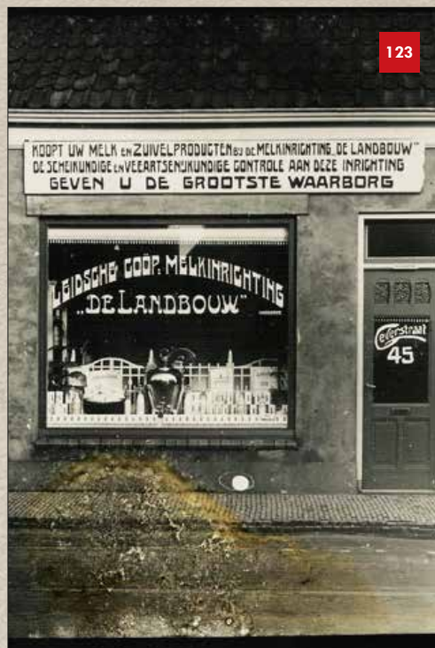
Anno 1925: pand Geversstraat 45, tussen Deutzstraat en Rhijngeesterstraatweg, van de Leidsche Coöperatieve Melkinrichting De Landbouw.
