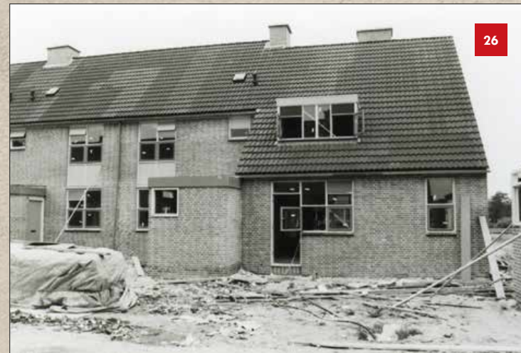
De nieuwbouw in Haaswijk. Hier zien we het Richard Holpad in aanbouw, 1981. Het was een van de eerste straten in de nieuwe wijk.
