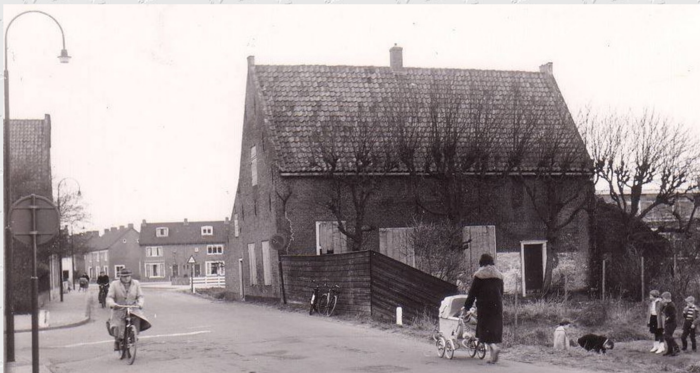
Op de foto onder is het pand nog bewoond, hier is het nog wachten op de afbraak.
