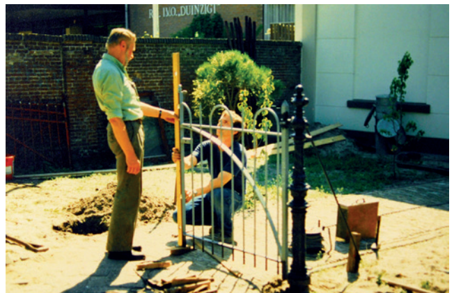
Plaatsen van de hekpalen.
