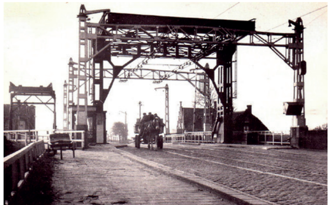
Haagsche Schouwbrug met trambaan, gezien vanaf de Oegstgeesterzijde, ca. 1950, met rechts op de achtergrond restaurant Het Haagsche Schouw. Digitaal fotoarchief Oegstgeest, collectie Loek de Groot.
