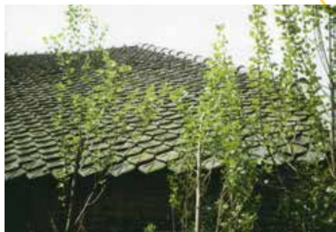
▲ Het dak van het koetshuis is gedekt met Oegstgeester pannen.
