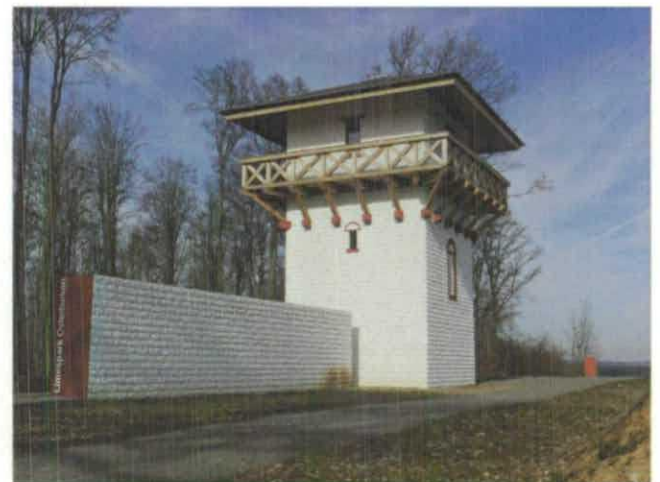
Herbouw van wachttorenen in limespark Osterburken, 2013 ( www.limesstrasse.de )
