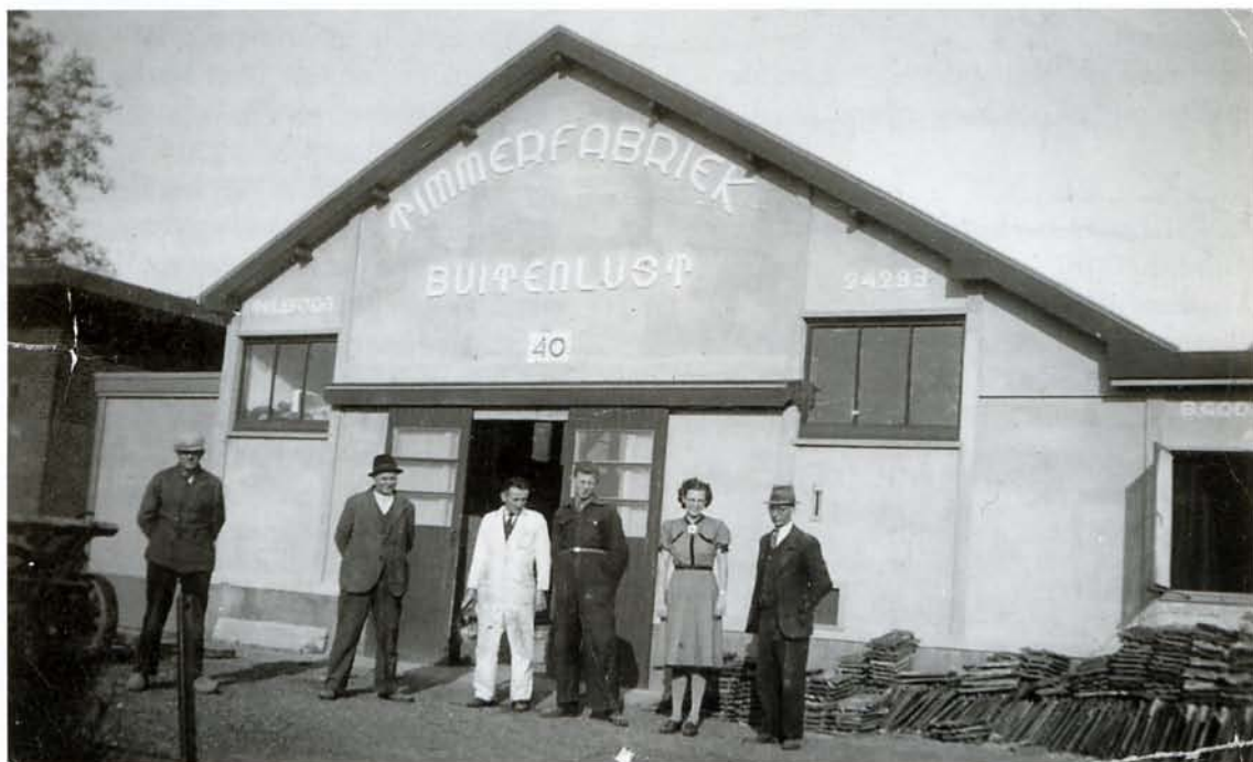
afb. 1 Timmerfabriek Buitenlust, Oude Rijnzichtweg 40 Oegstgeest
