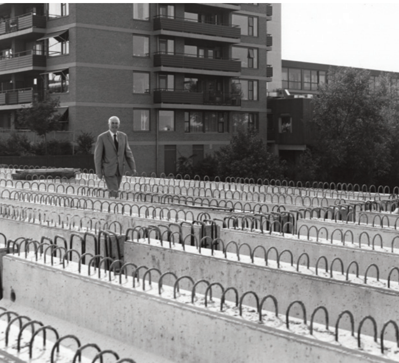
Burgemeester Van Eysinga op de Van Eysingabrug over het Oegstgeester Kanaal in aanbouw; op de achtergrond serviceflat Haaswijk, augustus 1979.
